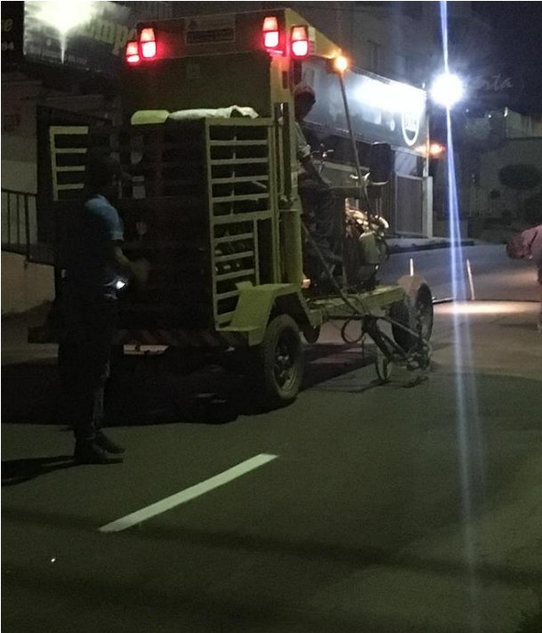
Figura 1: Acompanhamento da pintura da via.
