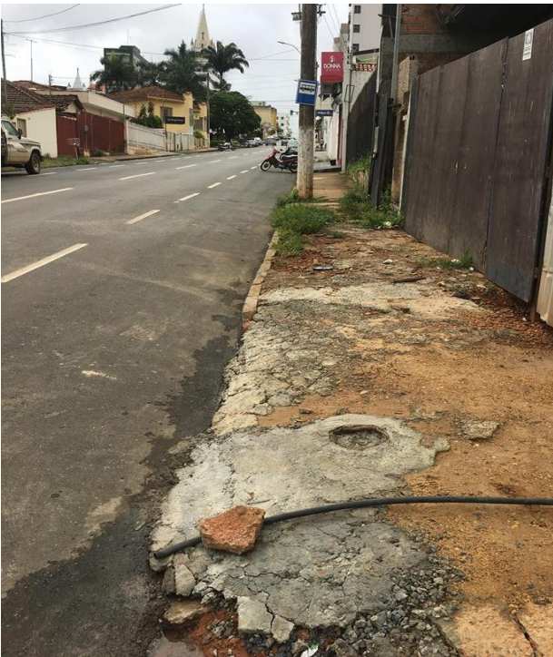
Figura 3: Situação precária do ponto de ônibus.
