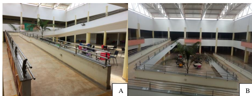
318 319 Figura 04 – Rampa do Prédio A. (A) – Vista do térreo. (B) Vista do pavimento superior.
