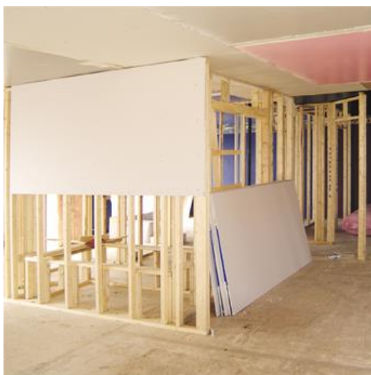
463 464 Figura 6 – Estrutura de madeira com forro de drywall. Fonte: (HOME & GARDEN RONA, 2017)
