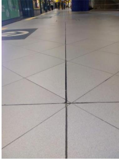
Figura 15 – Junta de dilatação dos pisos
