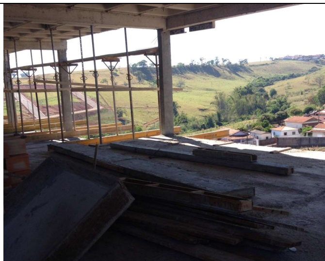
Figura 3: Canteiro de obras.
